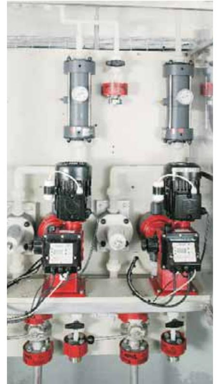
*Dosierstation mit Motor-Membran dosierpumpen MEMDOS DX, Pulsationsdämpfern PDS und Überströmventilen*
