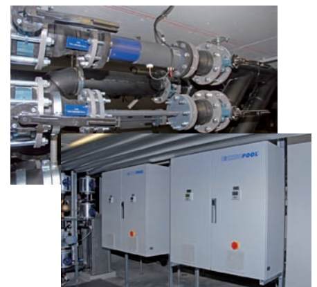
Technopool Elektrolyseanlage
