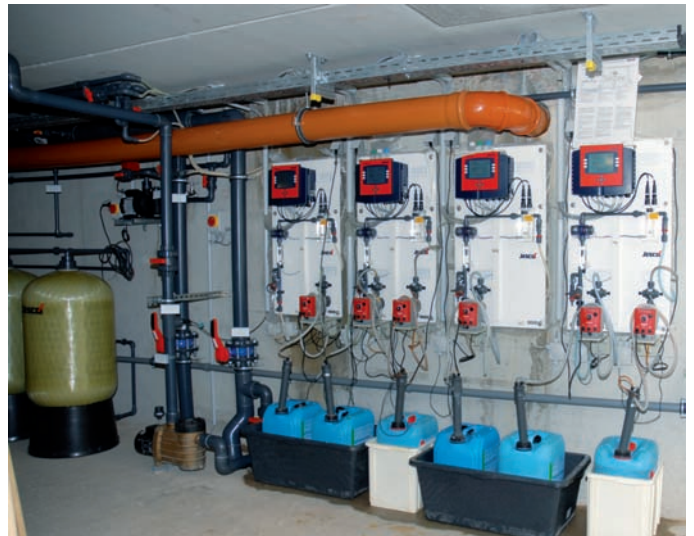
Mehrkanalregler TOPAX DX und Magnet-Membranpumpen MAGDOS LT
