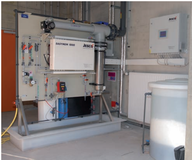
Membranzellen Chlor-Elektrolyseanlage EASYMEM 1000
