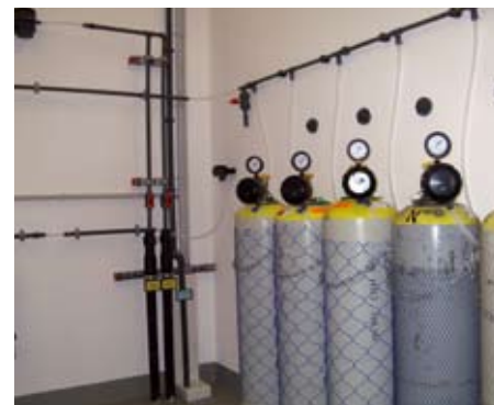
Chlorgasflaschen mit montiertem Regler C2213
