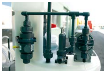
Optional können Pulsationsdämpfer zur Glättung von Druckschwankungen eingebaut werden
