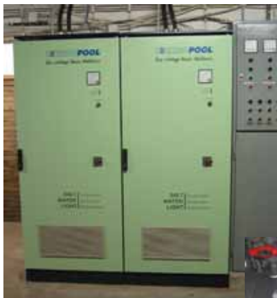
Zwei Technostar 4000AT Salzwasser Systeme mit entsprechenden Elektrolysezellen sind in Obernkirchen im Einsatz.
