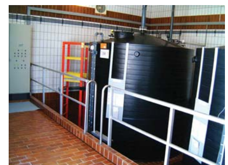
Tank 1 der Kläranlage Fürstenfeldbruck.
